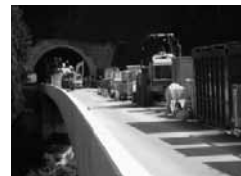
尾道松江線 トンネル工事
