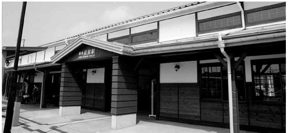
庄原駅 新駅舎
